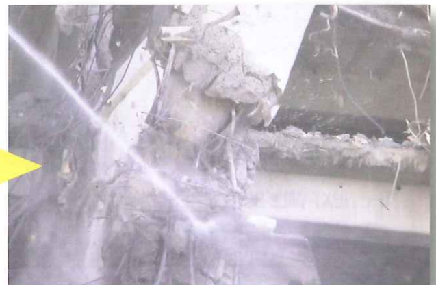
内部のH鋼が完全に切断された様子
