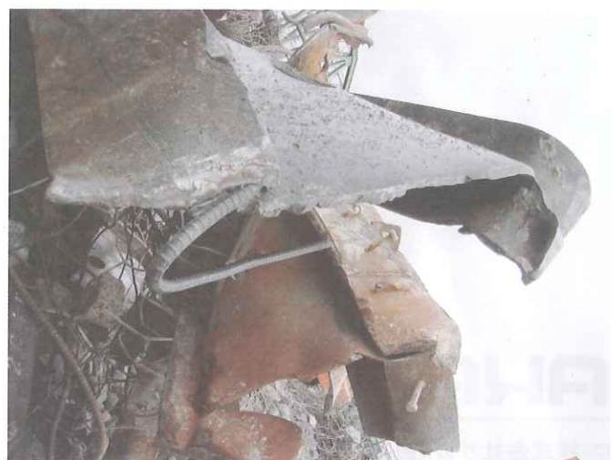
同現場にて切断された梁部のH鋼 H600×250 厚み20mm
