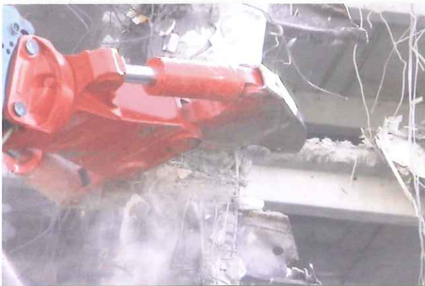
柱内部のH鋼を切断する様子
