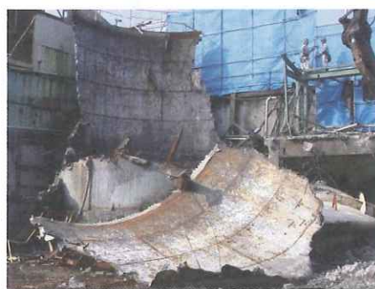
【写真右】 切断後のタンク 【写真左】 切断中のタンクの様子
