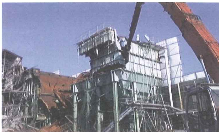
【写真】先端刃での穴あけ切断によるホッパー解体の様子
