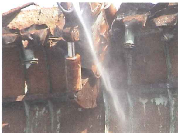
【写真】先端刃での穴あけ切断によるホッパー解体の様子
