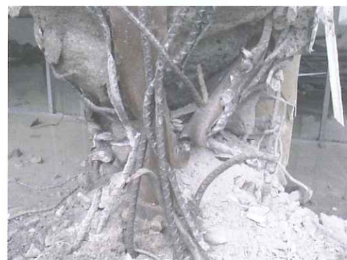
写真：皮むき作業（左）と5分で皮むきを終えたSRC柱の状況（右）
