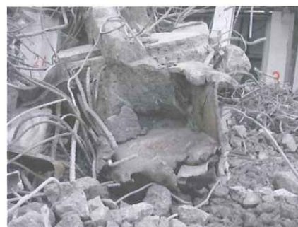
【写真】 5 分で H 形鋼切断を終えた状況
