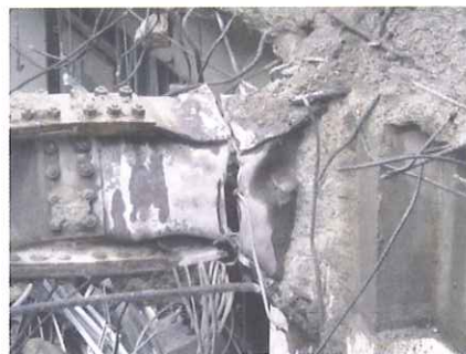
【写真】 梁「H500×200mm 厚み 20mm」の切断を終えた状況
