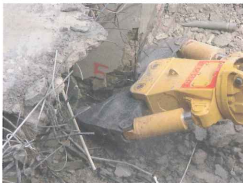
写真：皮むき作業（左）と5分で皮むきを終えたSRC柱の状況（右）
