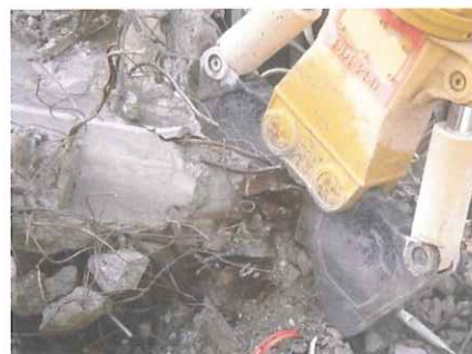
【写真】 SRC 柱の内部 H 形鋼切断中の状況
