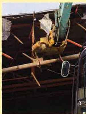
10 秒ごとに 5 か所連続でパイプを切断
