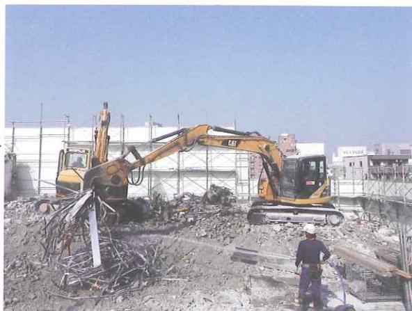
マグナム1200も使用していますが、階上現場ではあえてマグナム800を使用することが多いですね。その理由を具体的に作業内容で説明しましょう。小割作業以外にもガラや鉄筋の移動、鉄筋のまとめ作業、現場内の整理や鉄板移動、また壁倒しの際の相番作業等では、小割機で重量物を持ち上げたり、こまめに旋回したりするわけです。そういう時に小割性能と同時に、重量が400キロも軽いということがメリットになり、使い回しが良くなるのです。特に狭小の階上現場ではこれらを全て1台でやらなければならぬのですから、なおさらなのです。後方小旋回仕様に装着しても重量バランスに対して非常に安心できるマグナム800はこうした現場で重宝するのです。
