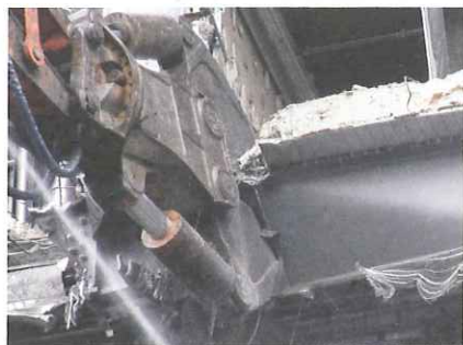
先端刃での穴あけ & 切断の様子
