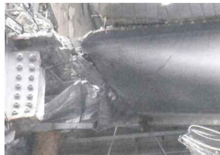
こじらない一発切断による切れ口
