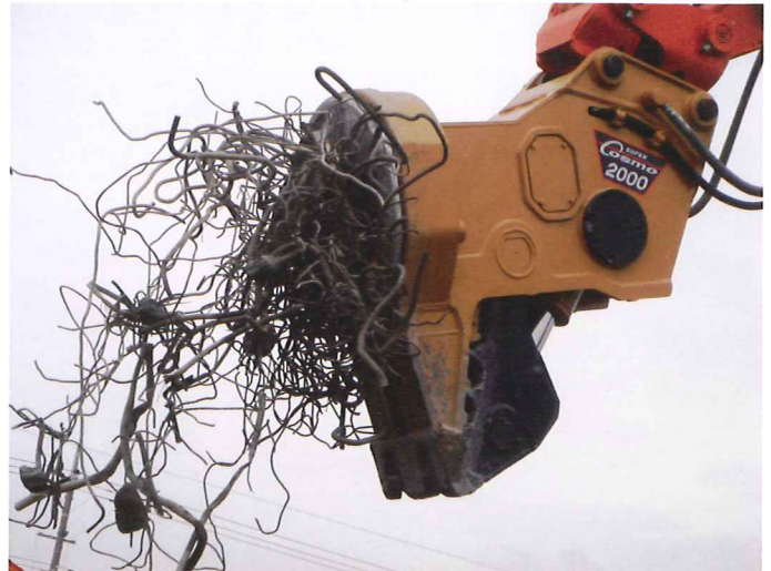
(RC現場でのマグネット使用状況)
