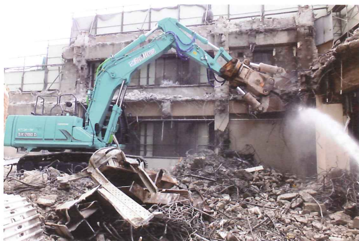
SRC造の階上解体現場で作業するSK260ビックヘッド。SRC解体機SDS400SRCアームが装着されている。見た目にもスタンダードと思えるデザイン。
