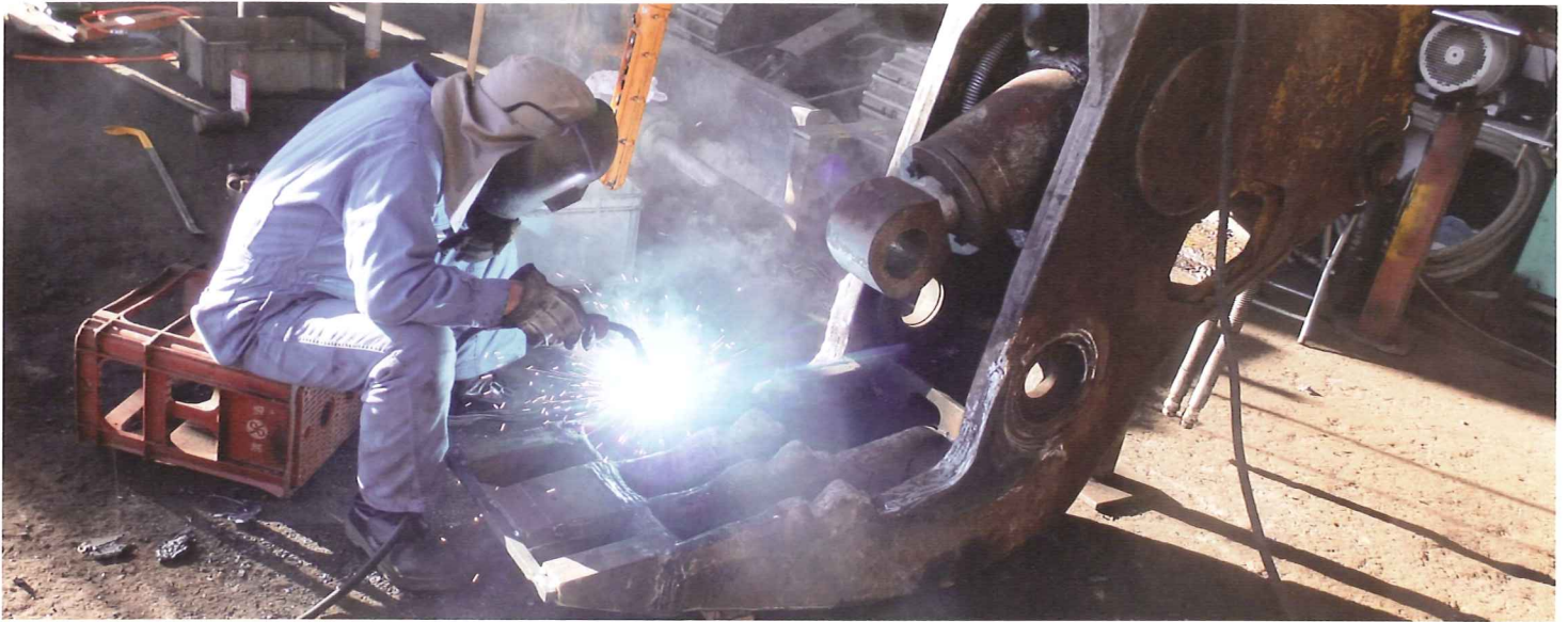
製造後27年を経過してなお使用されている「パクラSPAC70-5」。ツース交換と整形肉盛溶接の作業を行う溶接作業場の様子。メインシャフト部付近には修理で取り付けられたと思われる補強板が溶接されているのも見える。修理を施しながら長年丁寧に使用し続けていることがわかる。熟練の技を醸し出す小割機に巡り合えた。
